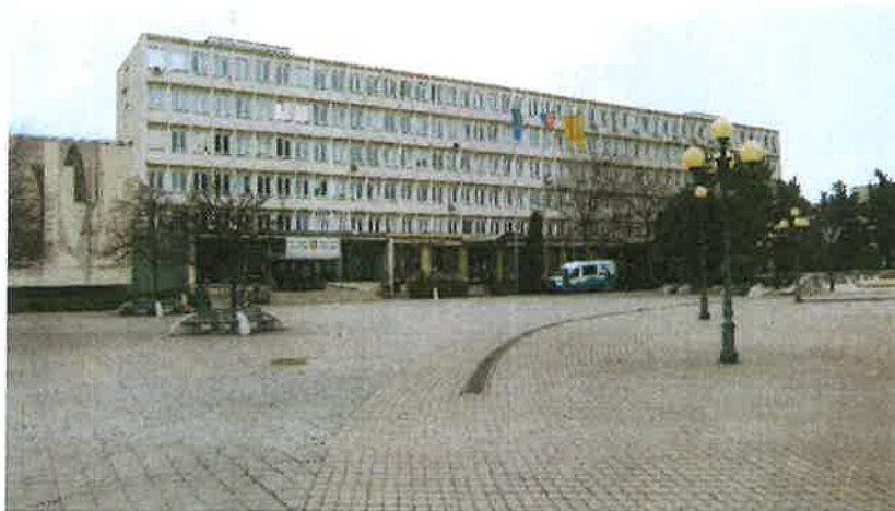
Pohľad čelný – Mierové námestie Galanta
