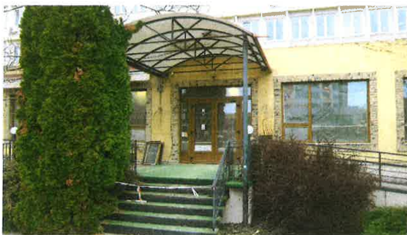
Pohľad čelný s hlavným vstupom do reštauračného zariadenia
